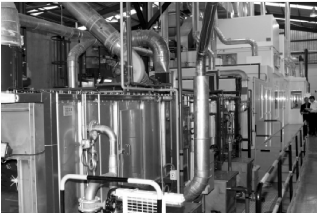
2 – La zona de los servicios de la línea de lavado, desde la entrada
