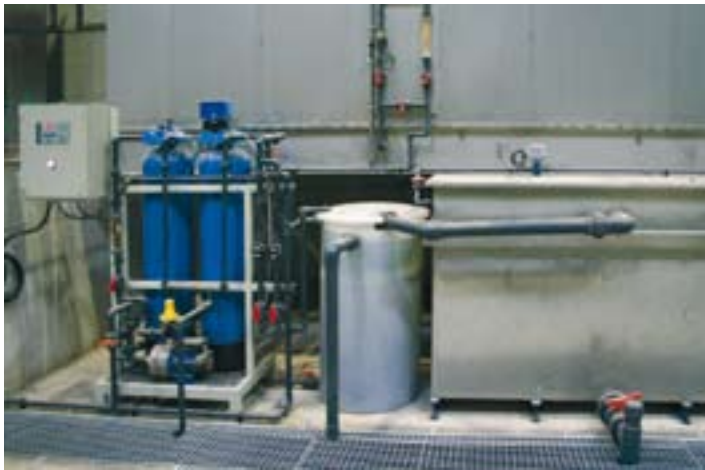
11 – El desmineralizador de producción del agua para dos enjuagues de cascada inversa.
