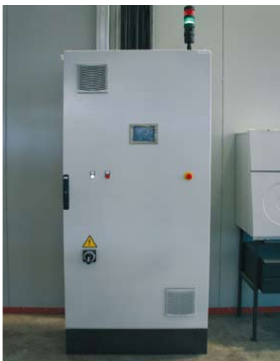
18 – Los cuadros periféricos y los dispositivos de control del sistema de aplicación y de los reciprocadores.
