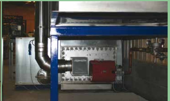
11 – Entrada en el túnel de pre-tratamiento.
